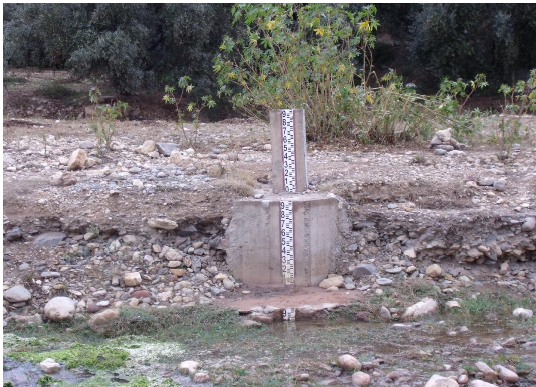
ECHELLES LIMNIMETRIQUES DE LA RIVE GAUCHE DE 0m à 3m
