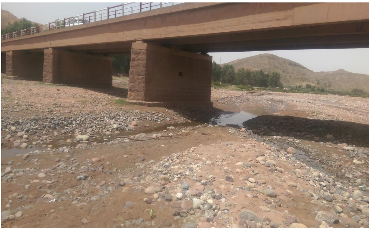
Figure 26: Le pont sur la Route
