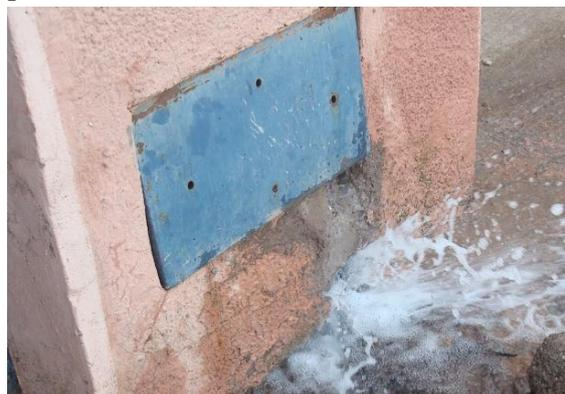
**Photo 9 : exemple d'une fuite au branchement**
