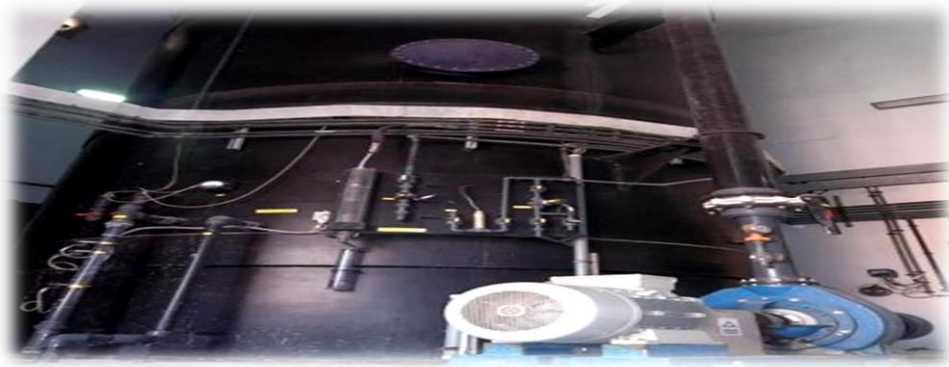
Figure 22 : Désodorisation physico-chimique et biologique
